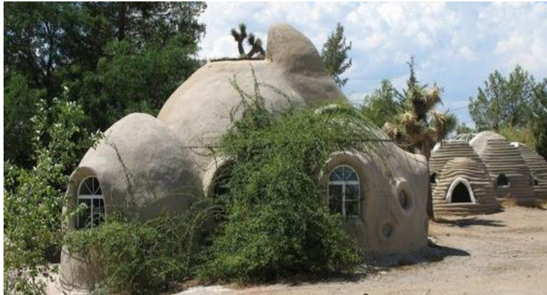
الشكل 18 مبنى منشئ بطريقة الاكياس الرملية.
