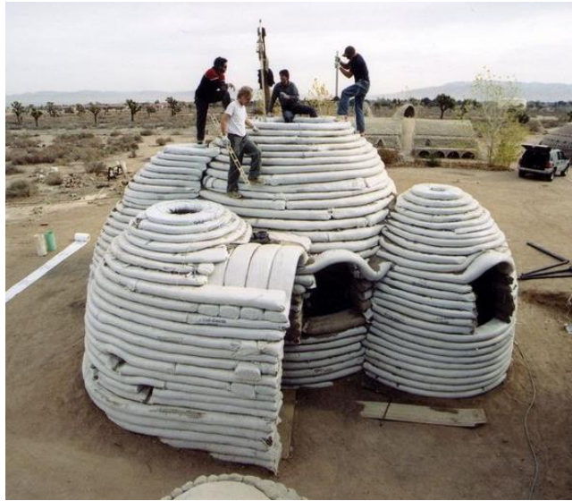
الشكل 17 يبين إنشاء مبنى بطريقة الاكياس الرملية.
