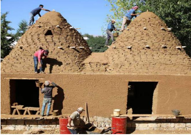
الشكل 5 يبين مبنى القبة أثناء البناء .
