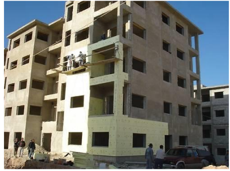
الشكل (9) العزل الحراري للجدران الخارجية لإحدى الأبنية السكنية في المشروع (بونس).
