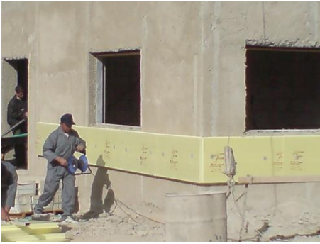
الشكل (9) العزل الحراري للجدران الخارجية لإحدى الأبنية السكنية في المشروع (بونس).
