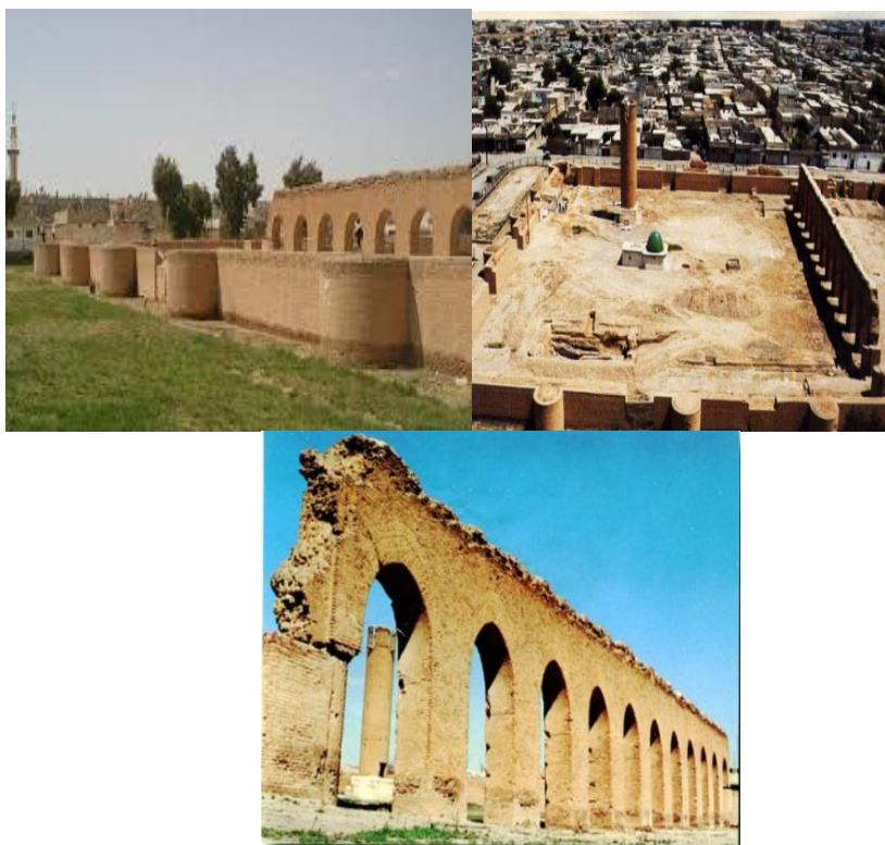
الصورة (1) مسجد الجامع الصورة (2) واجهة الحرم في جامع العتيق. الصورة (3) القنطرة التي تشكل واجهة الحرم
